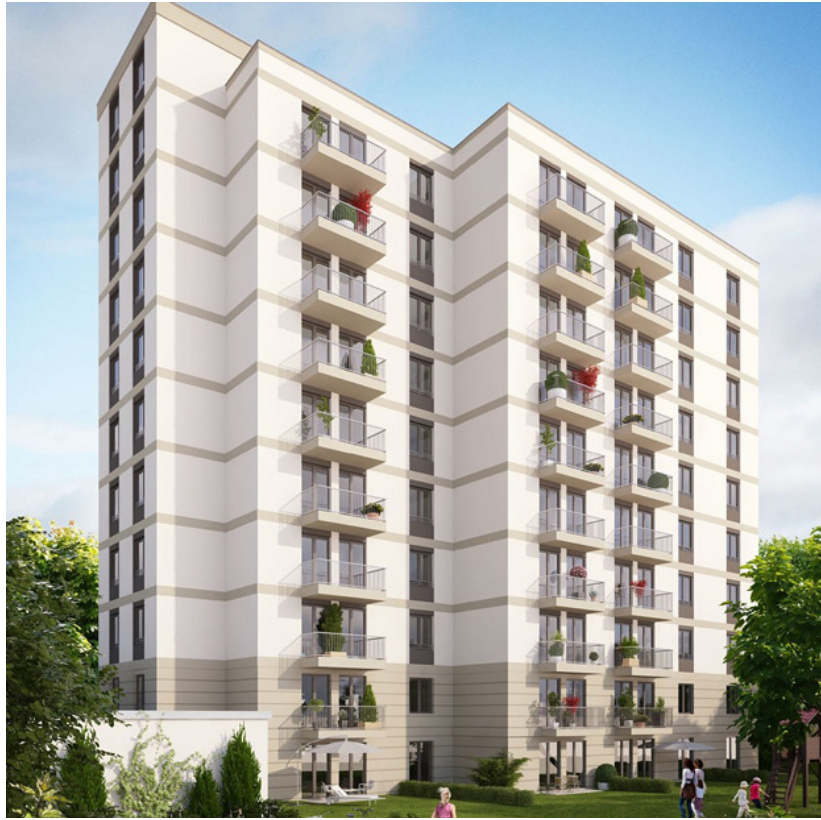
HOWOGE-Wohnhochhaus am Rosenfelder Ring 13 in Berlin-Lichtenberg; Copyright: HOWOGE
